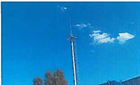
Рис.4. Прожекторная мачта с молниеотводом
